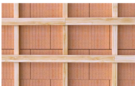
Sottostrutture di facciate.
