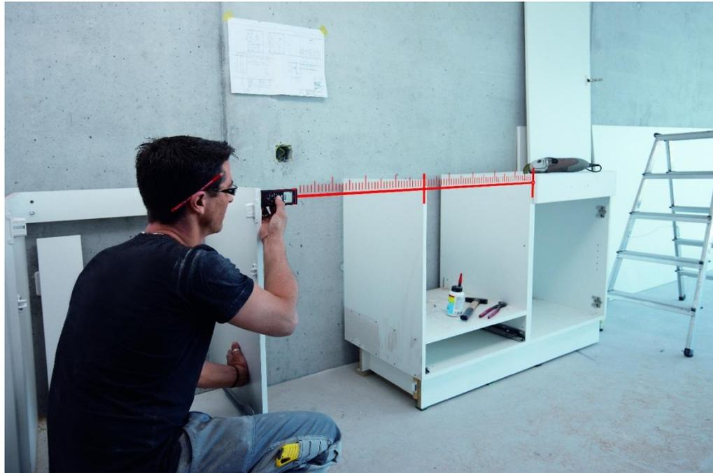
→ Con la funzione tracciamento i componenti vengono montati agevolmente
